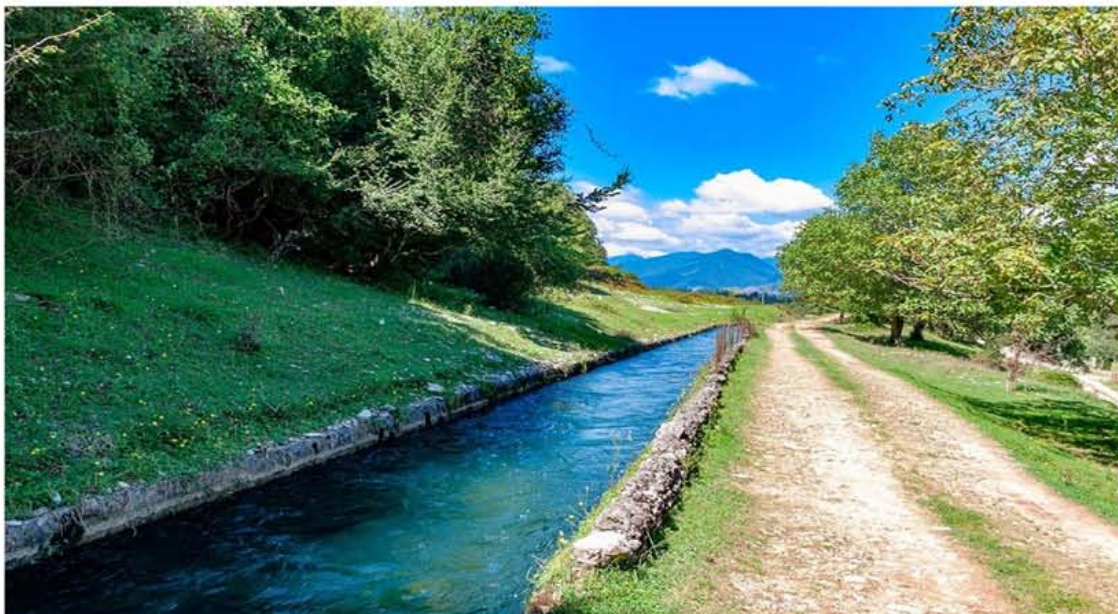
Georgia prioriza modernización plantas y sistemas tratamiento aguas residuales
